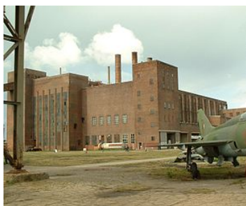
Das ehemalige Kraftwerk der Heeresversuchsanstalt Peenemünde (P. Wippermann)
