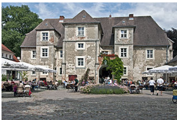
Wasserschloss Mellenthin, Frontseite (Zacke 82)
