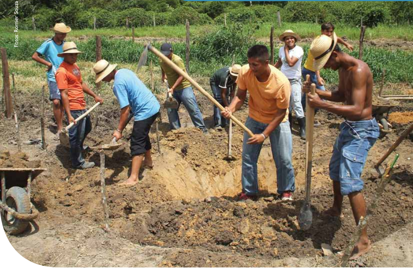
Mutirão para construção de horta circular
