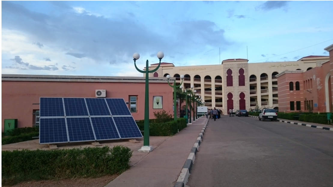
University Sultan Moulay Sliman of Beni-Mellal mit Solar Panel im Vordergrund
