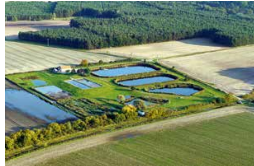
Abb. 69: Teichkläranlage Winkel, Stadt Uebigau-Wahrenbrück (Quelle: Stadt Uebigau-Wahrenbrück).
