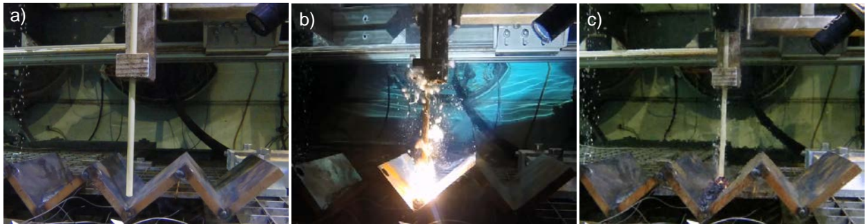
Abbildung 32: Aufnahmen eines Schweißvorgangs an einer Kehlnahtprobe in Wannenposition zu drei unterschiedlichen Zeitpunkten.
