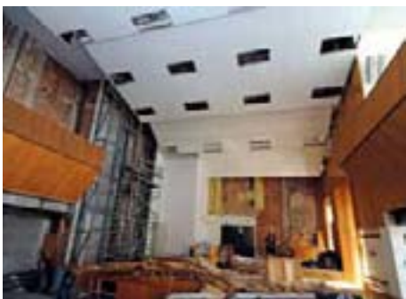
August 2012: Die Holzverkleidung der Galerien verdeckt über 200 Tonnen Beton, die rausmüssen.
