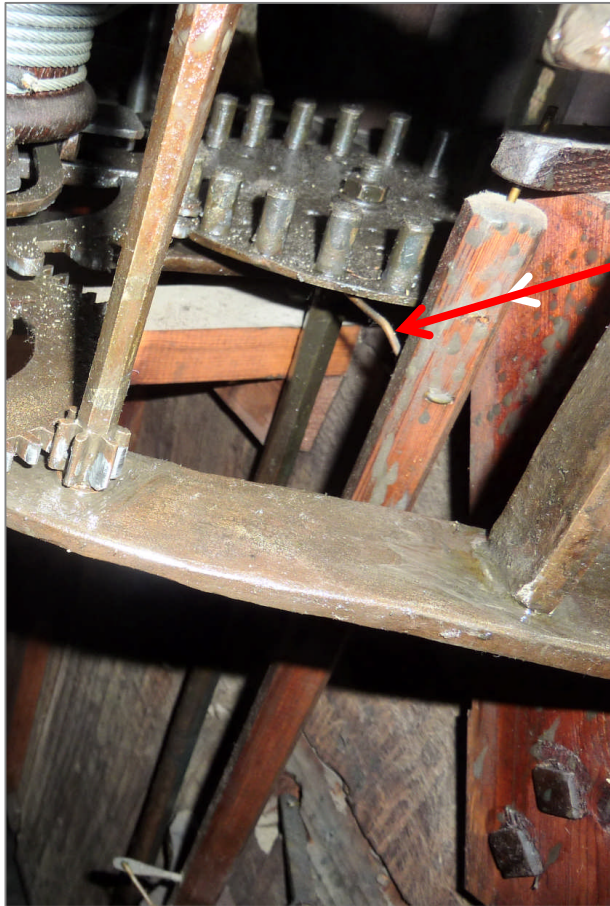
Detail der Steuerwelle für den Christusarm,
