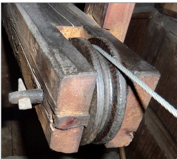
rechts eine neue Seilscheibe aus Holz, mit handgeschmiedetem Tragbügel, Messingachse und Stahlwelle nach historischem Vorbild
