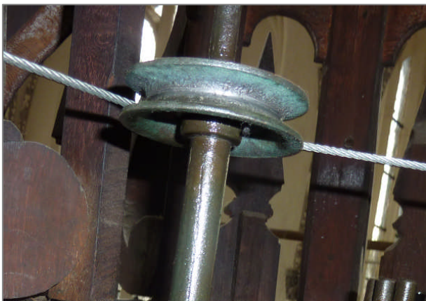
links Führungsrolle aus Stahl, mit einem Stahlseil, Detail aus der Gewichtsanlage des Apostelwerkes in Sankt Marien
