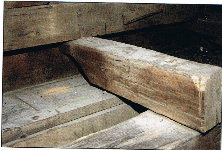
Kragbalken des ursprünglichen Baldachins
