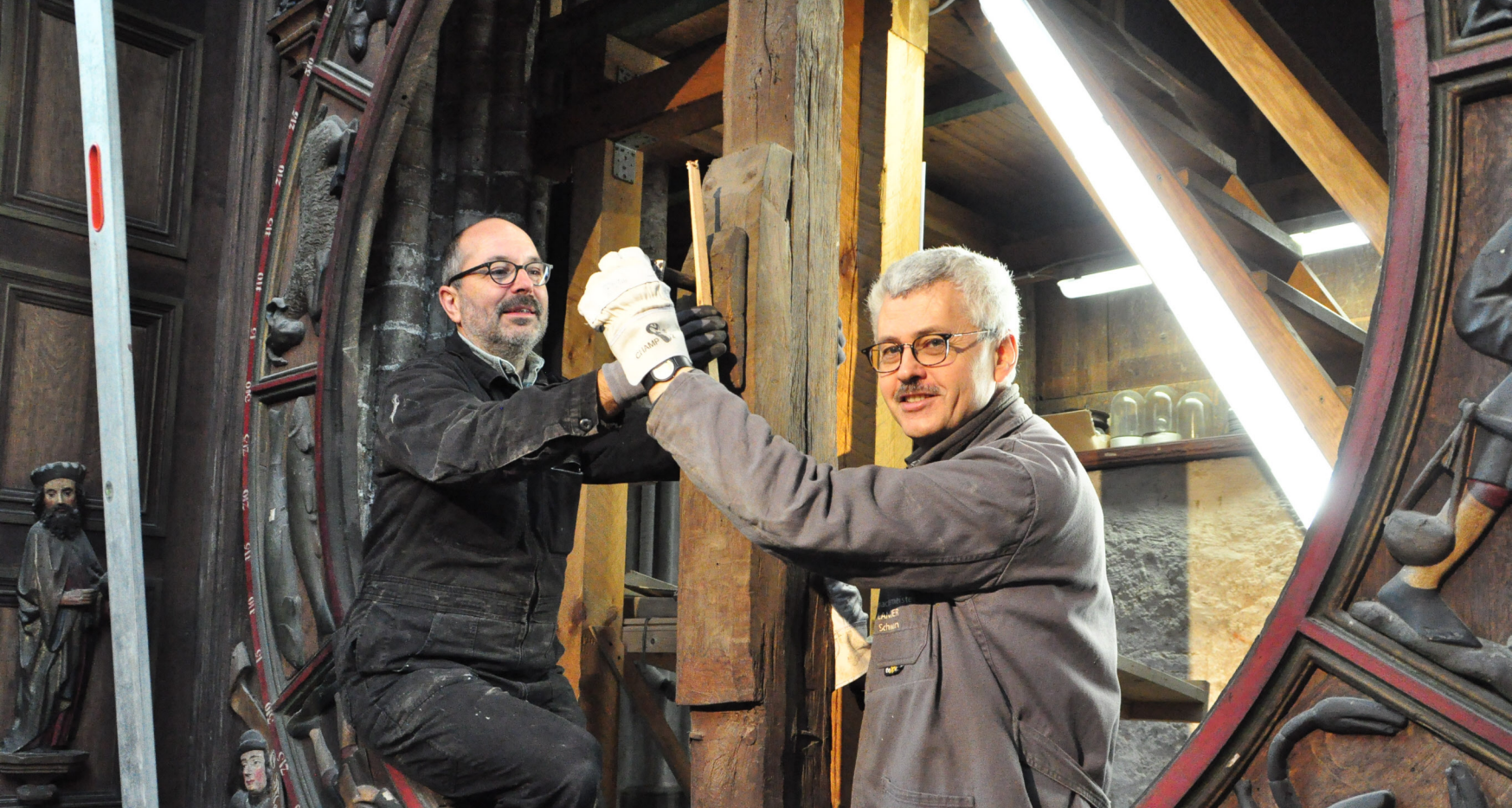
Die Uhrmachermeister Helmut Langner (r.) und Martin Kaczke erneuern und stärken die Aufhängung des Zifferblattes, bis die neue Eichenholzscheibe zum Jahreswechsel eingesetzt wird. Das Calendarium wird dann bis 2150 gelten – und soll so lange ohne weitere Arbeitsmaßnahmen durchhalten. FOTOS: KATRIN ZIMMER
