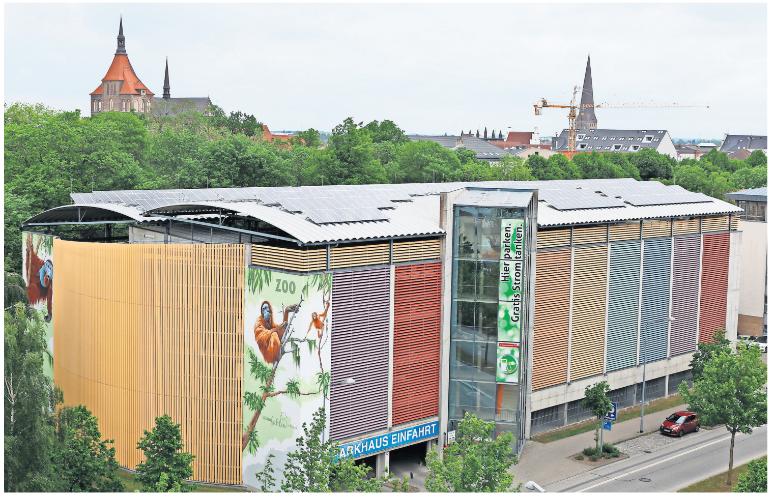
Auf dem Dach des Parkhauses in der August-Bebel-Straße ist eine Photovoltaik-Anlage installiert.
