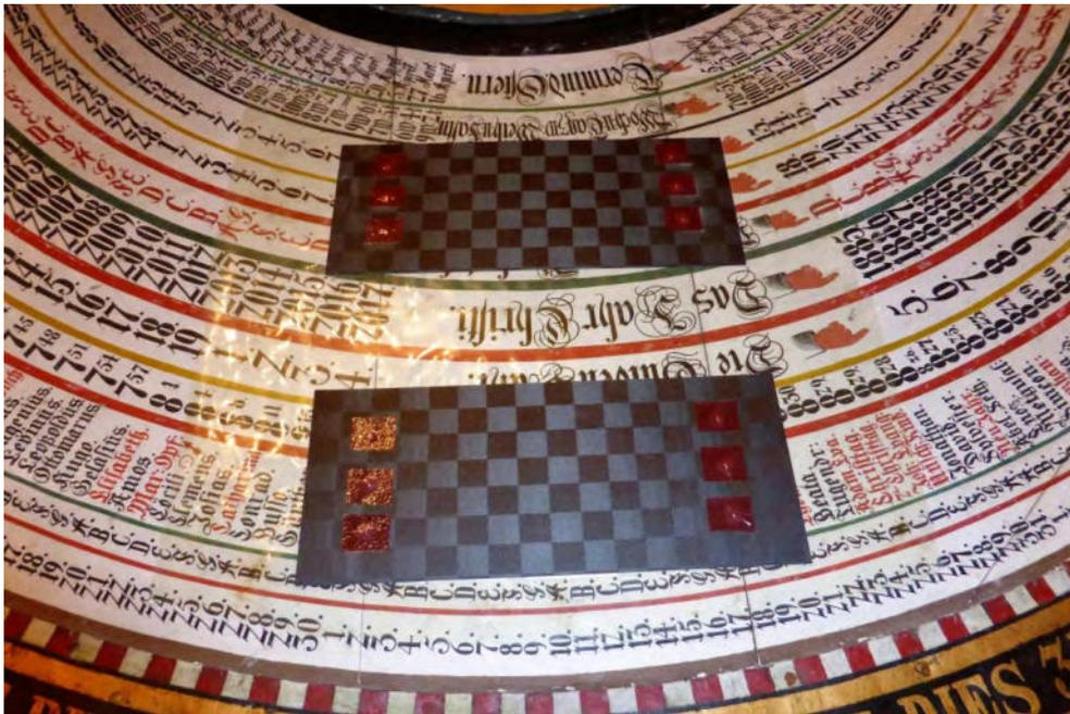
*Zwei der acht Karbonplatten, auf die die Vorsatzscheibe geklebt werden soll*
