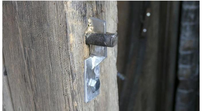
Die Lagerwelle wird mit einer neu angefertigten Halterung fixiert.
