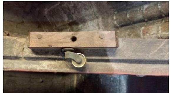
Die an der Rückseite angebrachten Führungsrollen werden neu positioniert.
